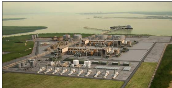
Ichthys LNG Plant, Darwin (image)
